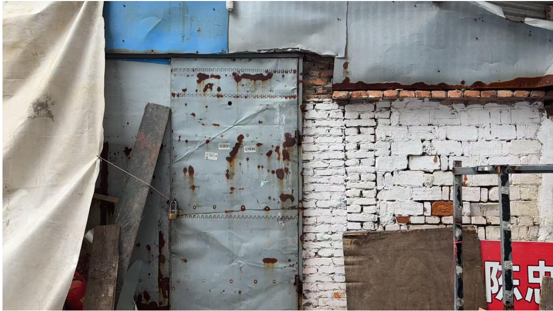
标的 1：办公楼南侧仓库
